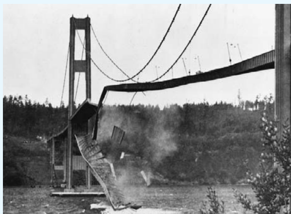
FIGURA 1 Gertrudis Galopante El colapso del puente Tacoma Narrows el 7 de noviembre de 1940 fue captado con una cámara de cine. Vemos una imagen de cuadro de esa película.
