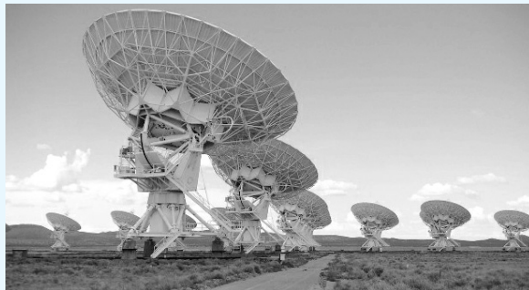
FIGURA 1 Radiotelescopios Algunas de las antenas de plato que forman el radiotelescopio VLA ( Very Large Array ) cerca de Socorro, Nuevo México. Hay 27 platos móviles, cada uno de 25 m de diámetro, que forman el conjunto dispuesto en una red en forma de Y. Los datos de todas las antenas se combinan para producir una sola imagen de radio. De esta forma, se logra una resolución equivalente a la de una antena gigante de radio (de unos 200 pies o 60 metros de diámetro).
