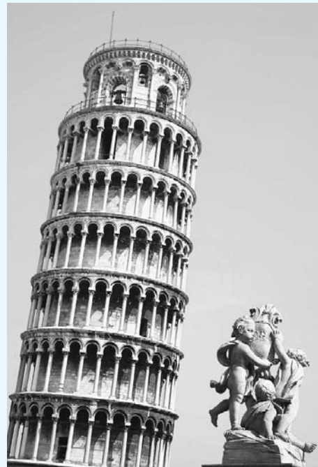
FIGURA 2 La Torre Inclinada de Pisa Construida como campanario para una catedral cercana, se edificó sobre un subsuelo inestable. Su construcción se inició en 1173, y comenzó a tenderse hacia un lado y luego hacia el otro, antes de inclinarse en su dirección actual. Hoy día, la torre diverge unos 5 m (16 ft) de la vertical en su parte superior. Se cerró en 1990 y se hizo un intento por estabilizarla y corregir la inclinación. Luego de cierta mayoría en la torre se abrió nuevamente al público.
