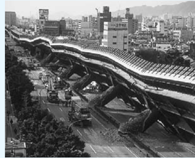
FIGURA 2 Malas vibraciones. Daños causados por el fuerte terremoto que asoló Kobe, Japón, en enero de 1995.
